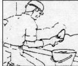
c) Introducir embudos en los orificios y colocar Inertol® Infiltración dejando que penetre el consumo indicado para cada espesor de pared.
